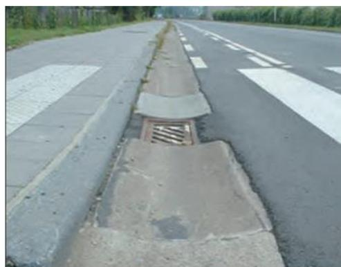
Figure 12: traversée inadaptée.
