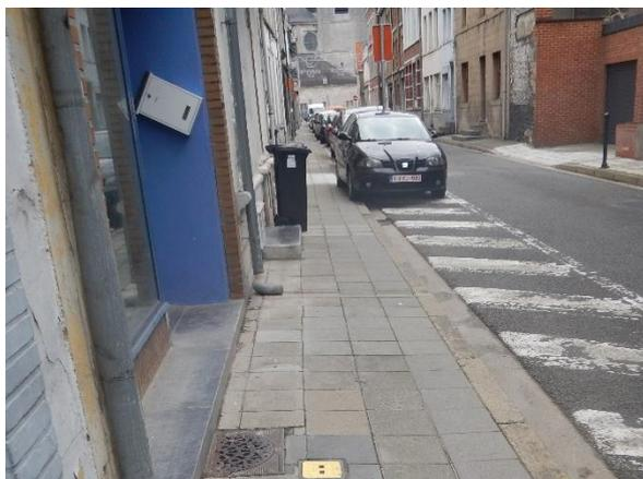
*Photo 35 : Largeur min. 1,20 m sur une longueur de plus de 0,50 m (Source : Agora, 2021)*
