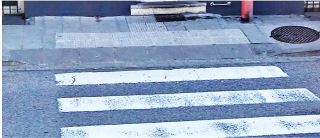
*Photo 39 : Traversées inaccessibles : pente de la rampe trop importante (Source : Agora, 2021)*
