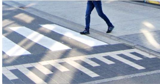
*Photo 40 : Traversées inaccessibles : pas de dalles podotactiles (Source : Agora, 2021)*
